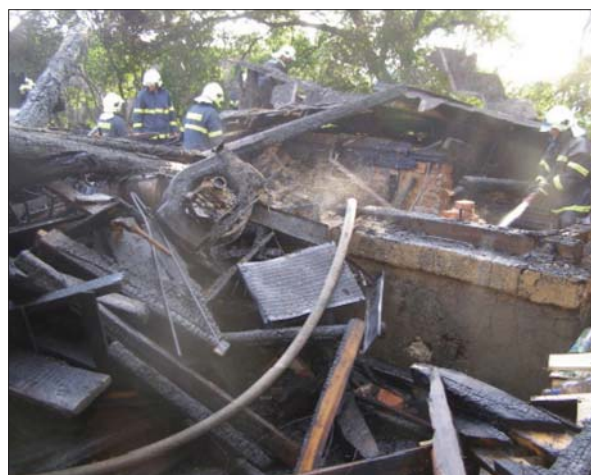
Obr. 6.2.1a Objekt bez hromosvodu po úderu blesku (foto: HZS ČR)
