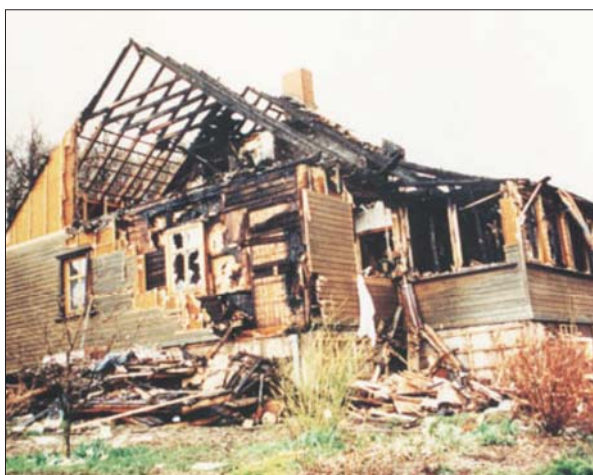
Obr. 6.2.1a Objekt bez hromosvodu po úderu blesku (foto: HZS ČR)
