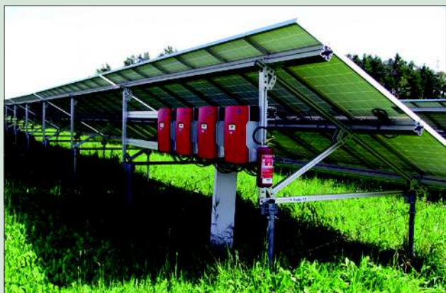
Obr. 6. Struktura FVE – solární park – nezávislé sekce
